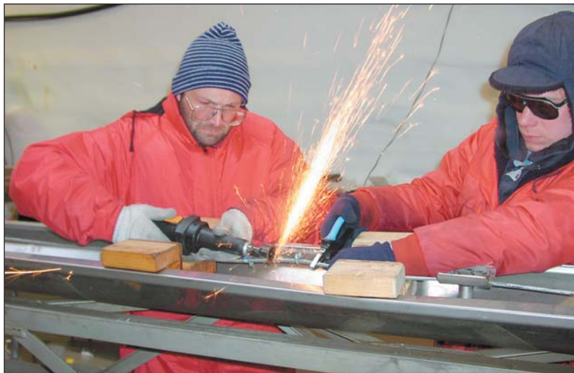
Обрезаем поврежденный участок кабеля (слева — автор статьи, справа — Ф.Уиллелмс).
